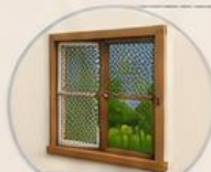
Menutup lubang ventilasi dengan kassa
